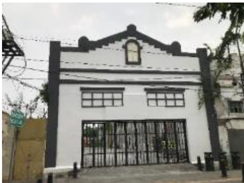
Gambar 82. Gerbang Entrance Tapak Jl. Cendrawasih Sumber: Dokumentasi Pribadi
