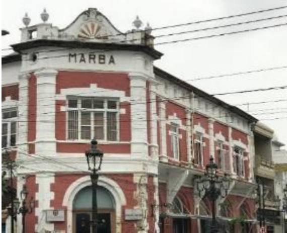
Gambar 69. Bentuk dinding dengan bata kliner Sumber: Dokumentasi Pribadi
