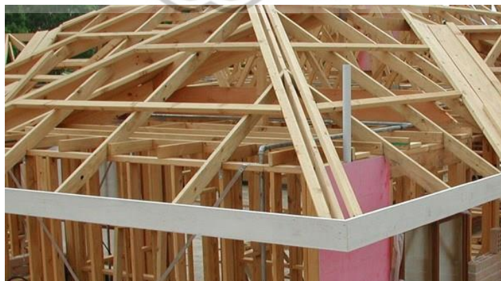
Gambar 37 Konstruksi Atap Kayu
