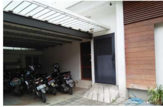
Gambar 4.192 Pintu Masuk R.Tangga (Sumber : Penulis)
