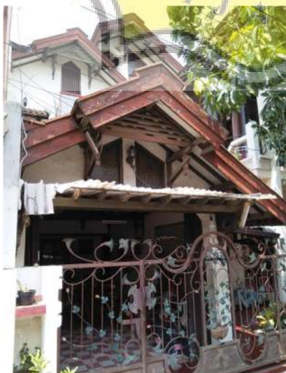
Gambar 4.144 Rumah Kantor PT.CKU Sumber : Penulis
