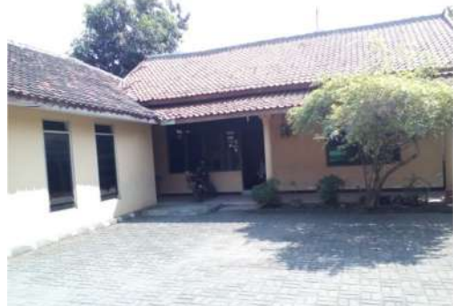
Gambar 4.167 Fasade Depan Rumah Kantor (Sumber : Penulis)
