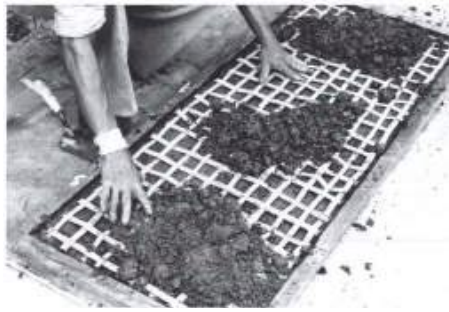
Gambar 5.6 Penerapan bambu pada slab Sumber : Bamboo The Gift of the Gods (2003)
