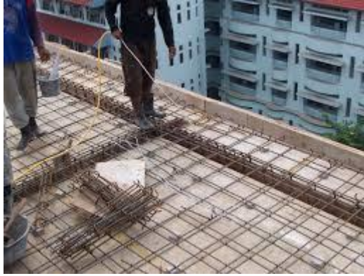
Gambar 80 Struktur atap (dak beton)
