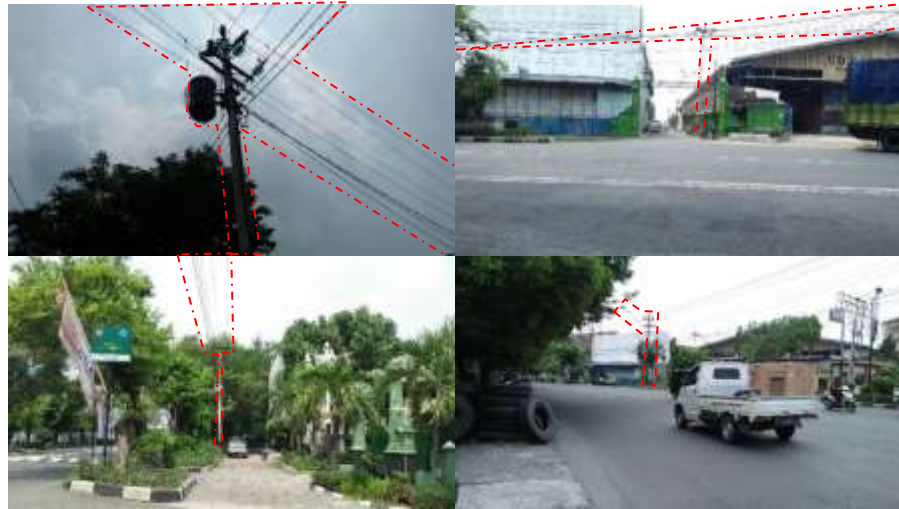
Gambar 53. Kondisi Utilitas Sekitar Tapak
