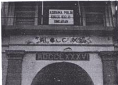
Foto no. 9/h. 95. Angka tahun di gedung sebelah barat (A) tampak Barat.
