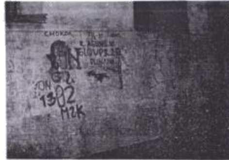
Foto no. 10/h. 200. Corat-coret di bangunan sebelah barat (A) ruang bagian bawah.
