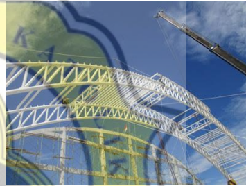
Kuda-kuda baja ringan atau pipa baja ringan
