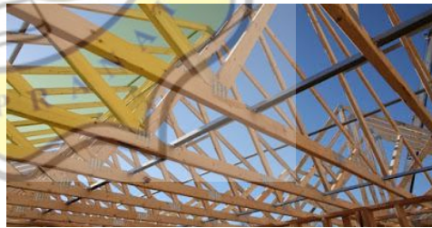
Kuda-kuda baja ringan atau pipa baja ringan
