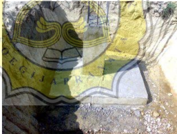
Gambar 6.16 Contoh pondasi foot plat
