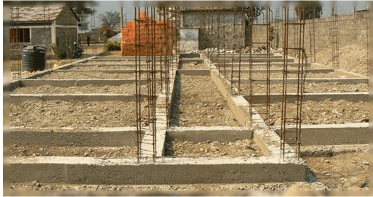
Gambar 6.21 Contoh sloof/tie beam
