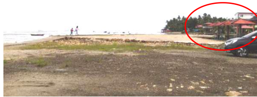
Gambar 3.3 Bangunan non permanent sekitar pantai sorake
