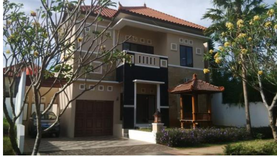
Gambar 30. Perumahan Beranda Bali BSB City
