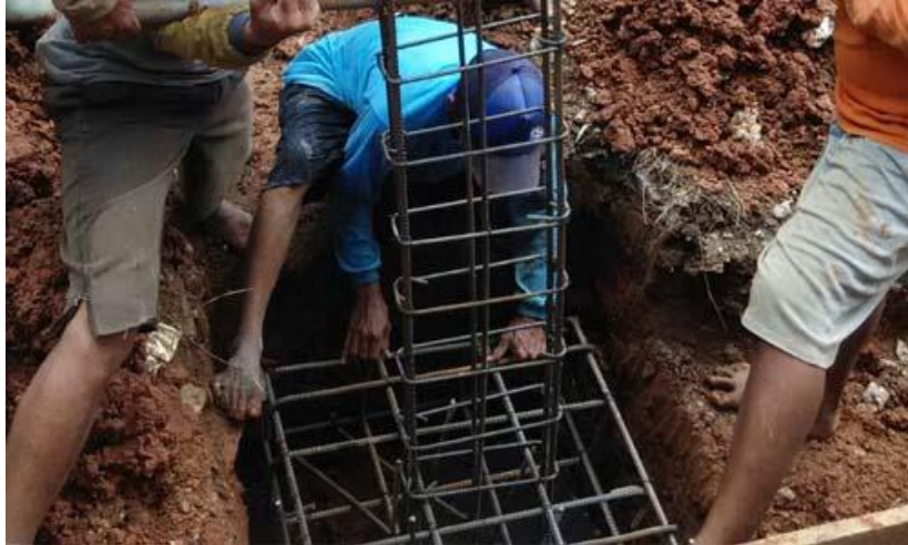
Gambar 5 6 Struktur Pondasi Foot Plat
