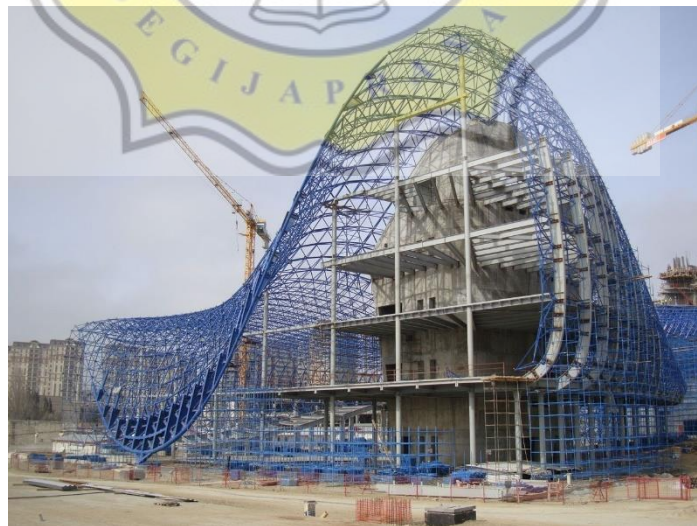
Gambar 7 4 Struktur Space Frame
