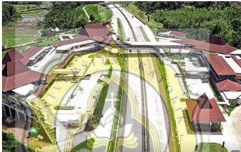
Gambar 26 Atap Pada Bangunan Rest Area
