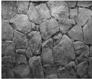
Gambar 128. Dinding Batu Alam
