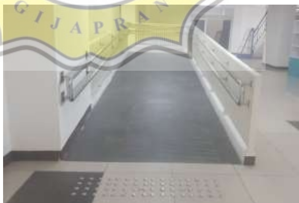
Gambar 47. lantai dengan lapisan karet anti slip
