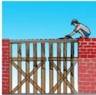
Gambar 15 Pemasangan bekisting pada tutup bangunan PAH
