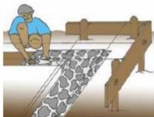
Gambar 5 Pemasangan pondasi
