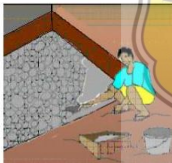
Gambar 24 Pemasangan batu kali dan adukan
