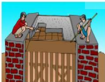
Gambar 19 Pekerjaan pengecoran tutup PAH
