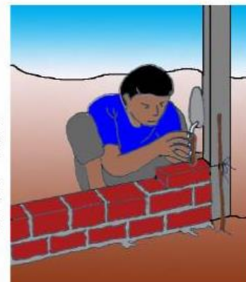
Gambar 12 Pemasangan dinding PAH
