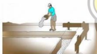
Gambar 3 Pemberian pasir pada lantai pondasi
