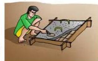
Gambar 20 Pembesian dan Pengecoran tutup manhole
