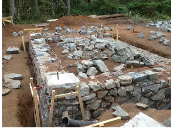
Gambar 43 Kondisi di Lapangan
