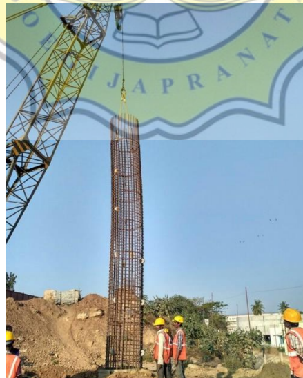
Gambar 40 Pemasangan Tulangan Borepile
