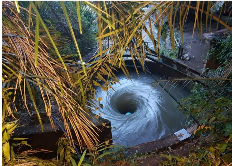
Gambar 83 Mini Hydro Green School Bali (Sumber: Google.com)
