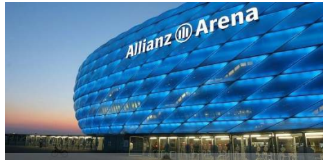
Gambar 6. 1 penerapan ETFE pada fasade di Allianz Arena
