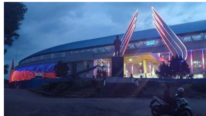
Gambar 6. 3 penerapan LED fasade pada Stadion Jatidiri
