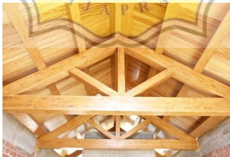
Gambar 45. Konstruksi Kuda-kuda Kayu ekspose
