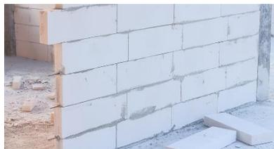
Gambar 47. Susunan Bata Ringan
