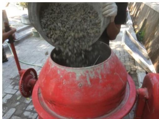
Gambar 4.43 Proses Memasukan Agregat Kasar
