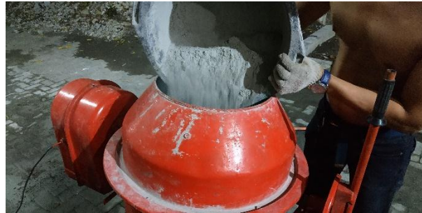
Gambar 4.62 Menuangkan Semen ke dalam Concrete Mixer
