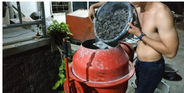
Gambar 4.61 Menuangkan Agregat Kasar ke dalam Concrete Mixer
