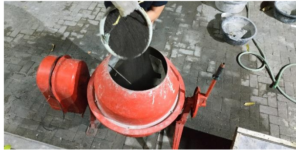
Gambar 4.49 Penuangan Agregat Halus ke Concrete Mixer
