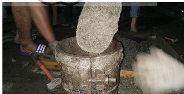
Gambar 4.77 Memasukkan Beton ke dalam Cetakan
