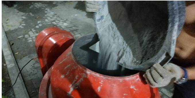
Gambar 4.38 Penuangan Semen ke Concrete Mixer
