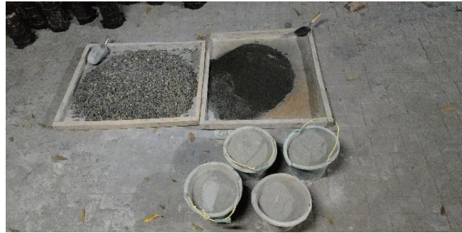
Gambar 4.35 Material dan Alat Siap Digunakan
