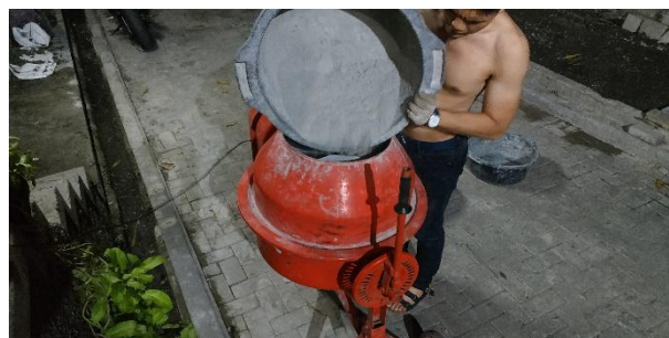
Gambar 4.73 Menuangkan Semen ke dalam Concrete Mixer
