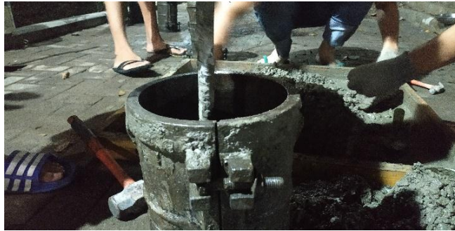
Gambar 4.39 Adukan Beton Sedang Dirojok
