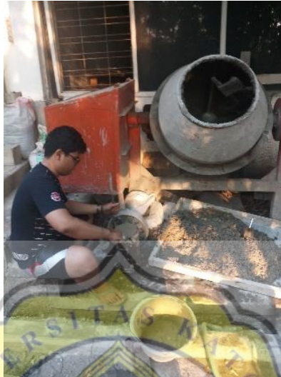
Gambar 4.59 Adonan Beton Siap Dicetak
