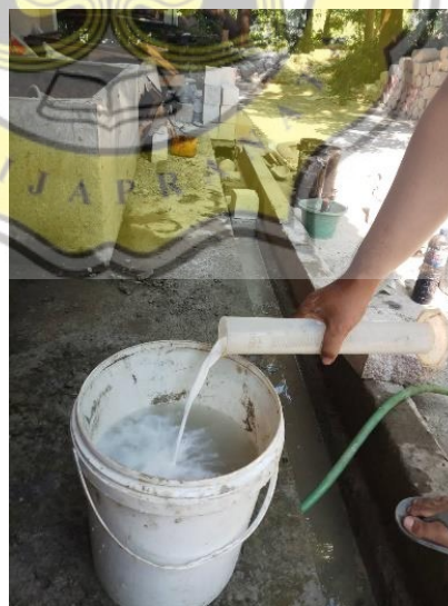
Gambar 4.62 Proses Memasukan Polymer Concrete
