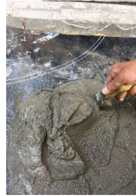
Gambar 4.4 Pengadukan Mortar
