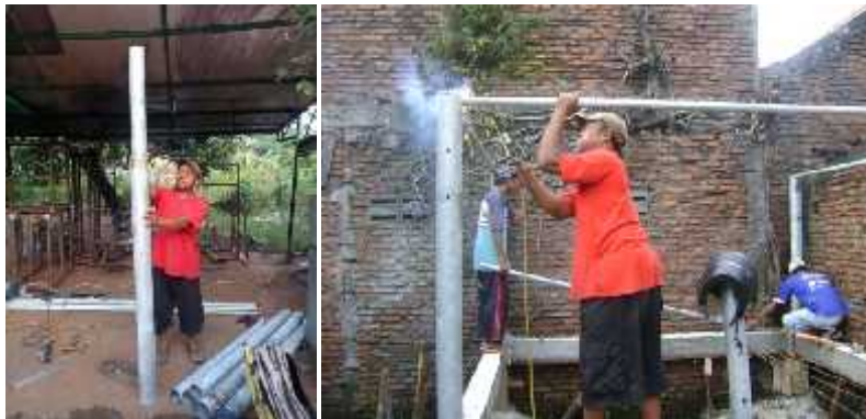
Gambar 5.14: Pembuatan dan pemasangan tiang hidrolis dari pipa galvanis
