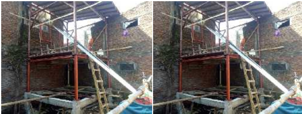
Gambar 5.17 Pemasangan atap bangunan sebelum dilakukan uji tiang hidrolis
