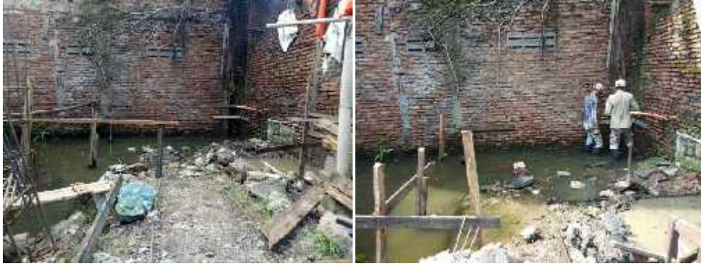
Gambar 5.6: Pengukuran dan pemasangan bouwplank di lokasi pembangunan
