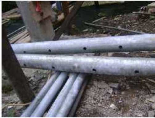
Gambar 5.13: Pipa galvanis yang akan digunakan untuk tiang hidrolis dan regel
