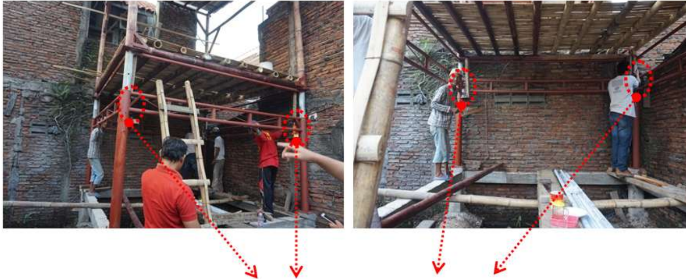
Posisi dongkrak pada empat sudut lantai
