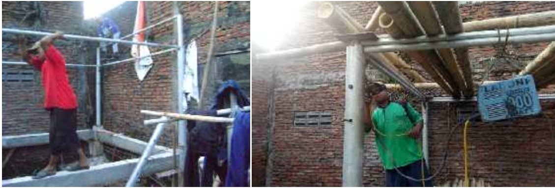
Gambar 5.15: Pemasangan tiang dan regel serta pemasangan landasan dongkrak pada tiang bagian luar
