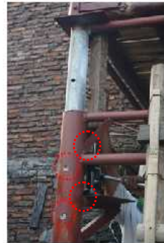
Posisi lubang yang harus dikunci jika sudah mencapai ketinggian yang diinginkan
