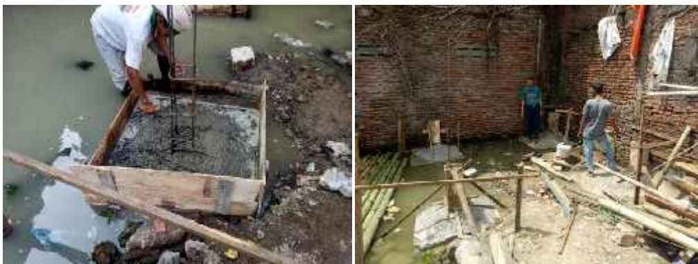
Gambar 5.10: Pengecoran beton pondasi foot plat beton bertulang.
