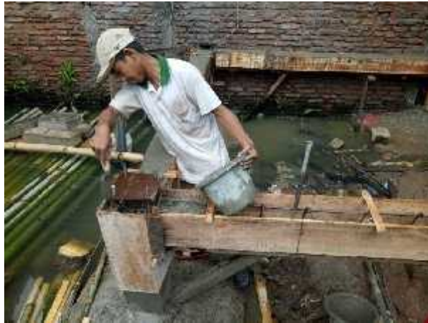
Gambar 5.11: Pengecoran kolom beton dan sloof
