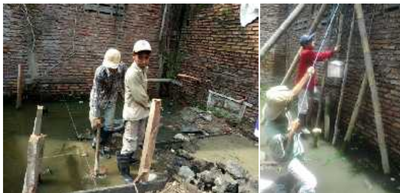
Gambar 5.8: a. Pengukuran dan penentuan titik pondasi
