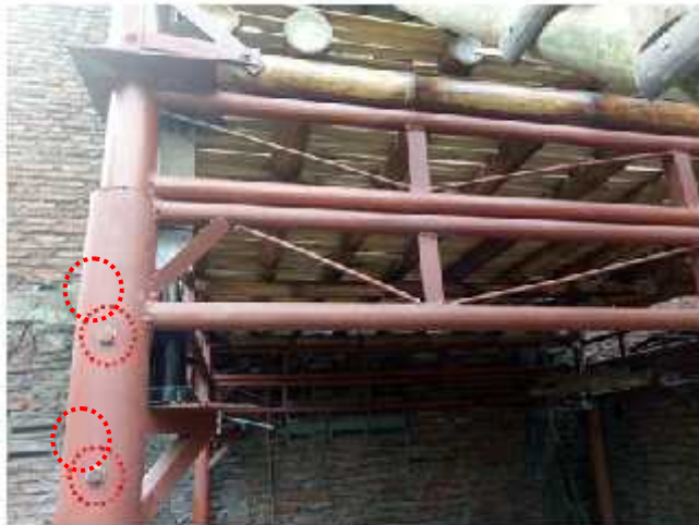
Posisi lubang yang harus dikunci jika sudah mencapai ketinggian yang diinginkan
