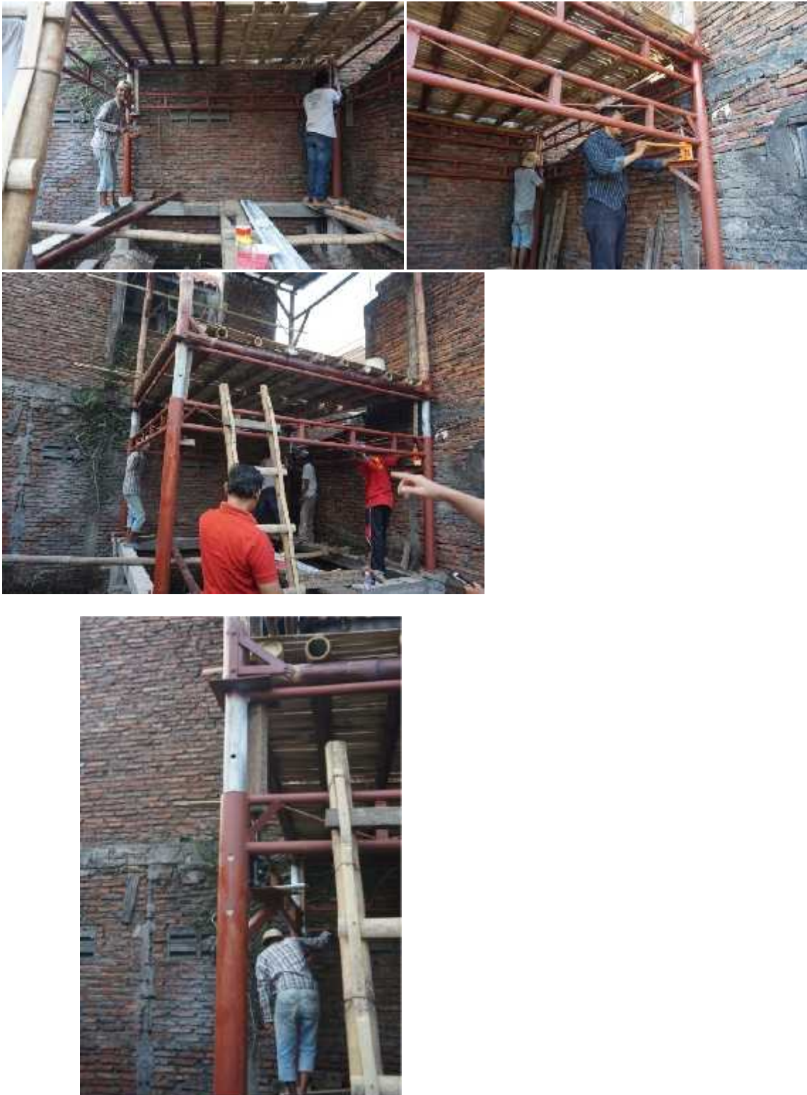
Gambar 3: Cara mendongkrak rumah hidrolis yang dilakukan pada 4 titik tumpuan (tiang)
