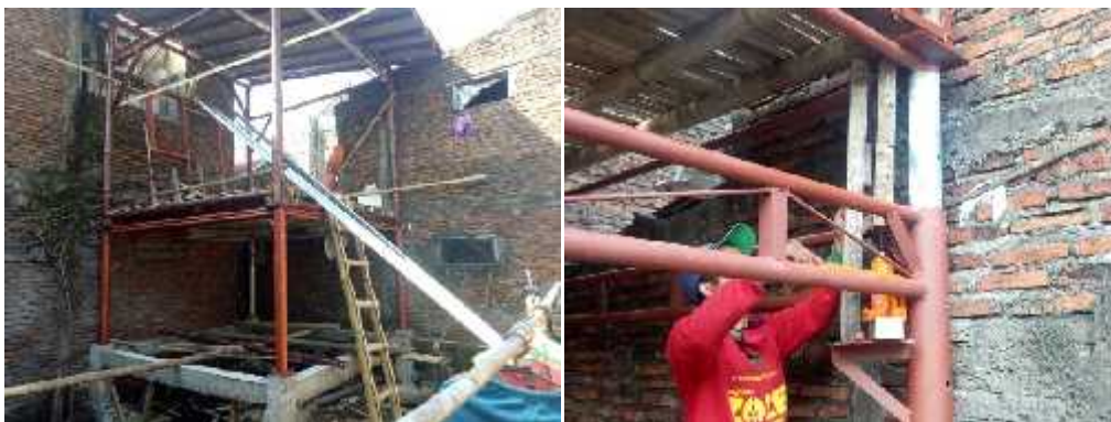
Gambar 5.21: a. Regel tunggal yang kurang kuat menahan beban b. Reigel yang sudah dibuat double dan cukup kuat menahan beban .
