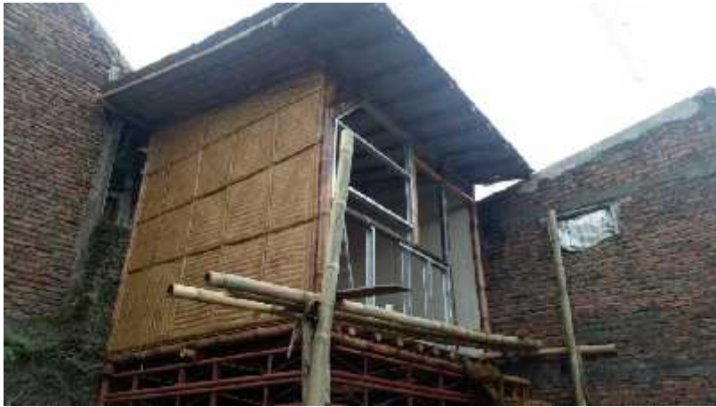
Gambar 5.18: Pemasangan dinding rumah terdiri atas dinding luar anyaman bambu (“gedeg”), dinding dalam ditutup dengan kalsiboard
