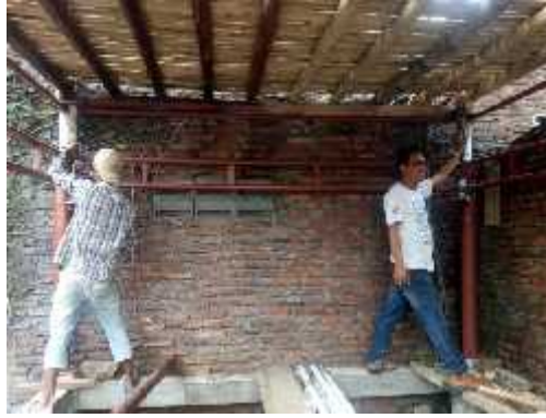
Gambar 5.22: Uji coba tiang hidrolis yang harus dilakukan oleh satu orang pada tiap titik tumpuan/tiang.
