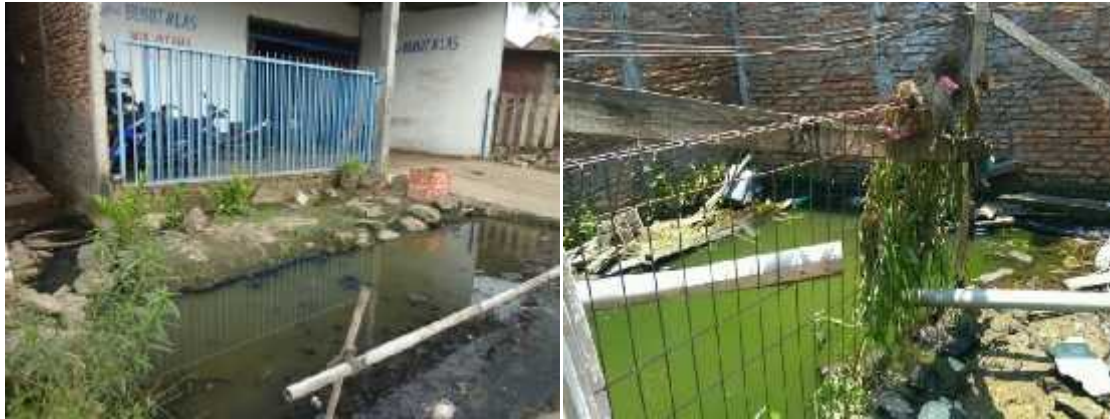
Gambar 1.2: a) Genangan air di tepi jalan b) Genangan air rob yang terdapat di halaman tengah rumah Sumber :Data Peneliti. 2017
