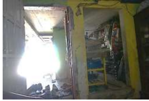
Gambar 4.5 : kondisi rumah tinggal yang lantainya dinaikkan, sehingga jarak lantai dengan plafon sekitar 150 cm. Kondisi dalam rumah tersebut dimana lantai bagian dalam lebih rendah dari lantai bagian depan yang dinaikkan. Sumber : dokumentasi peneliti, Januari 2020
