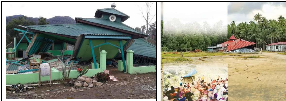
Kedua bangunan ini runtuh sebagian namun konstruksi atap relatif aman
