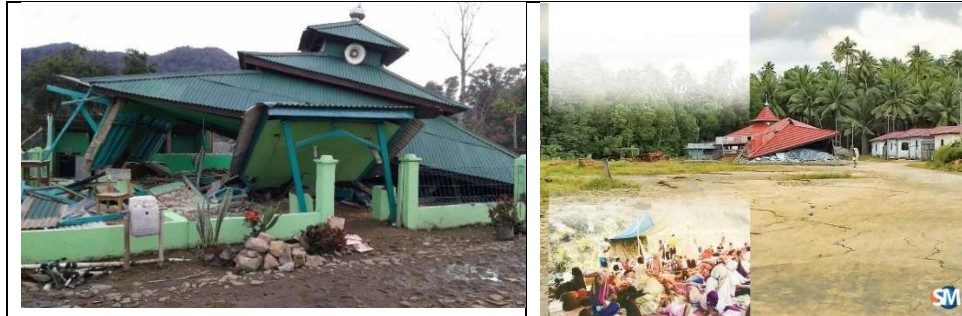
Kedua bangunan ini runtuh sebagian namun konstruksi relatif aman
