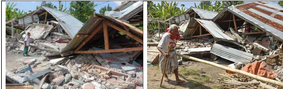
Atap berbentuk pelana, masing-masing terlepas dari induknya namun secara satuan atap tetap utuh, semuanya lepas dari tumpuannya
