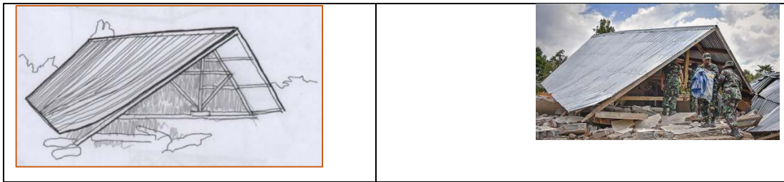
Gambar 12: Model kerusakan rumah beratap pelana ber ahan asbes gelombang
