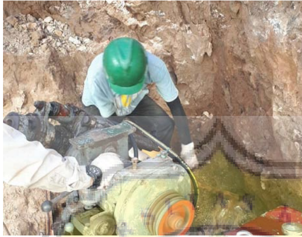
Gambar 3.6. Detail pengeboran basah soil nailing (Sumber: dokumentasi pribadi, 2017)
