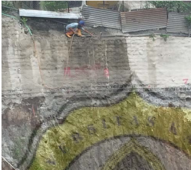
Gambar 3.13. Pembersihan selang menggunakan semprotan air (Sumber: dokumentasi pribadi, 2017)
