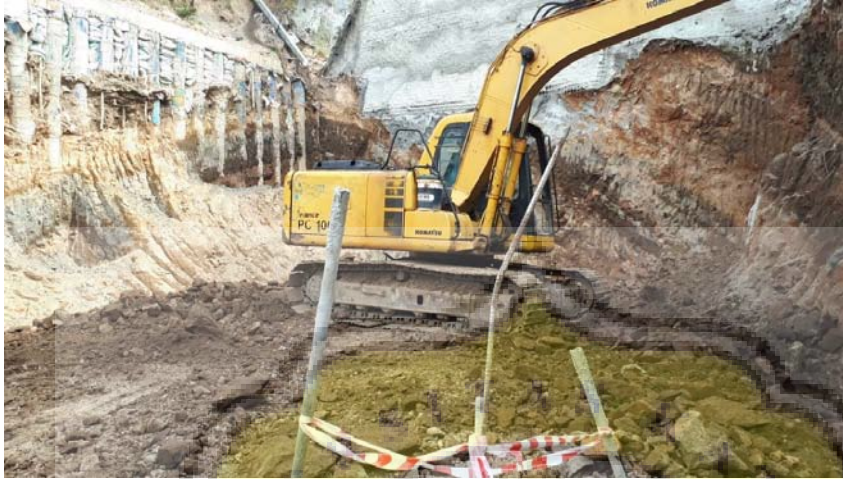
Gambar 3.1. Cutting lahan menggunakan excavator (Sumber: dokumentasi pribadi, 2017)
