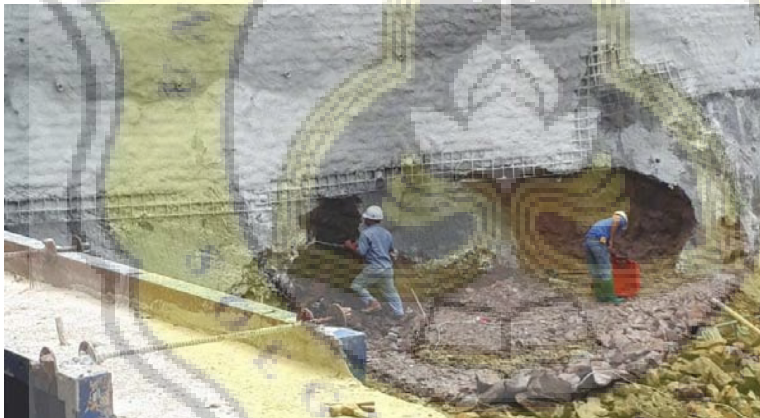
Gambar 3.2. Cutting lahan menggunakan mesin cipping manual (Sumber: dokumentasi pribadi, 2017)
