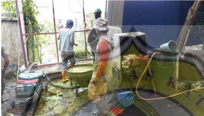
Gambar 3.7. Proses shortcrete (Sumber: dokumentasi pribadi 2017)
