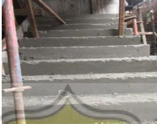
Gambar 4.27 Hasil pengecoran Tangga
