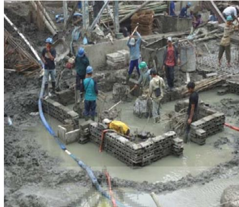
Gambar 4.3 Pemasangan Bata Ringan Sebagai Bekisting
