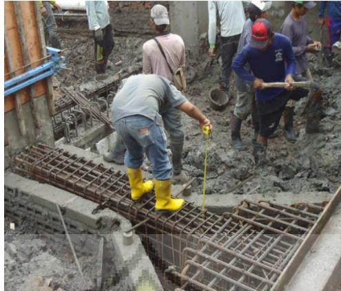
Gambar 4.6 Pemasangan Bata Ringan Sebagai Bekisting *Tie Beam*
