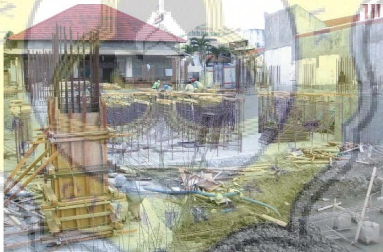
Gambar 4.10. Bekisting Kolom Konvensional
