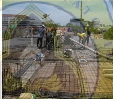
Gambar 4.19 Proses Pengecoran Plat Lantai dan Balok
