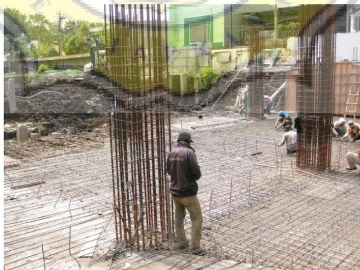
Gambar 4.9 Pemasangan Tulangan Kolom
