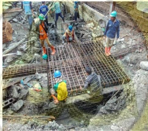
Gambar 4.2 Penulangan *Pile Cap*
