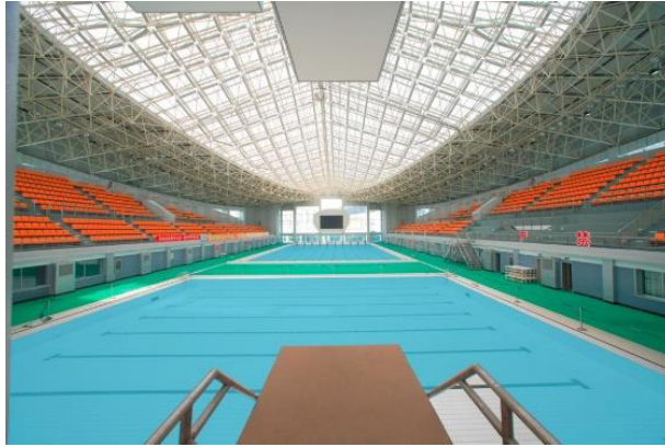
Gambar 42. Struktur Rangka Space Frame
