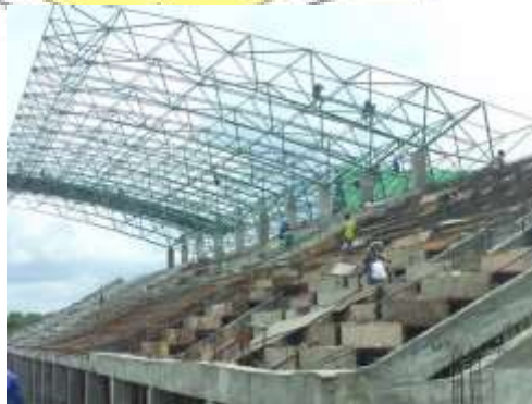
Gambar 5. 4 Struktur rangka atap bentang lebar
