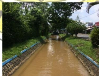
Gambar 3. 25 Saluran drainase didepan tapak Sumber : dokumen pribadi
