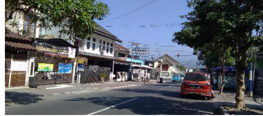
Gambar III-6 Kondisi Jalan Pierre Tendean
