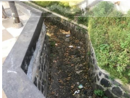
Figure 20 Saluran Drainase Sumber : Dokumentasi Pribadi, 2019
