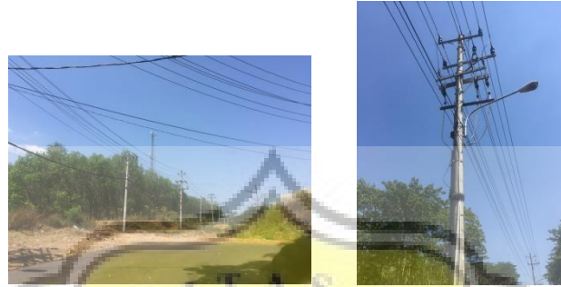
Gambar III.64 Utilitas di Sekitar Area Tapak Sumber: Dokumen Pribadi (2019)
