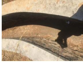
Gambar III.63 Kondisi Drainase di Sekitar Area Tapak Sumber: Dokumen Pribadi (2019)
