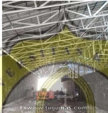
Gambar 10 Rangka Atap Baja
