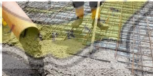
Gambar 20 Struktur Pelat Lantai Beton
