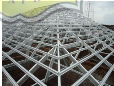
Gambar 17 Struktur Baja Ringan
