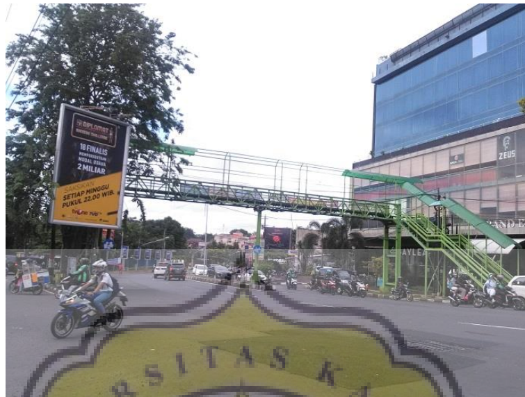
Gambar 3.1 Situasi JPO di Jalan Sultan Agung (Sumber: Dokumentasi Pribadi, diambil pada tanggal 13 Februari 2019)
