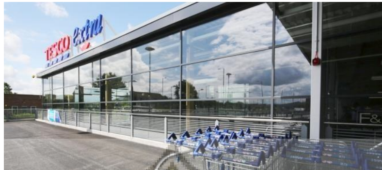
Gambar 7.12. Penerapan curtain wall
