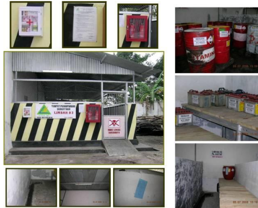
Gambar 5.13 Contoh Bangunan Tempat Penyimpanan Sementara Limbah B3
