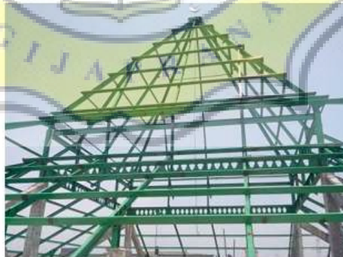
Gambar 7. 21 Struktur Atap Baja Sumber : https://www.atapkarya.id
