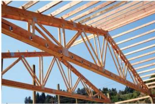
Gambar 7. 20 . Struktur Atap Kayu
