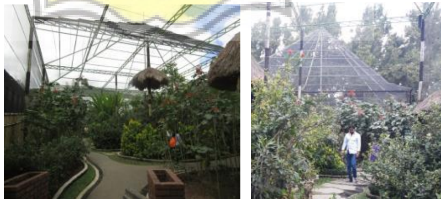
Gambar 105 Penggunaan paranet di Kemenuh Butterfly Park dengan bentuk atap limasan. Asumsi kerapatan 60-70%
