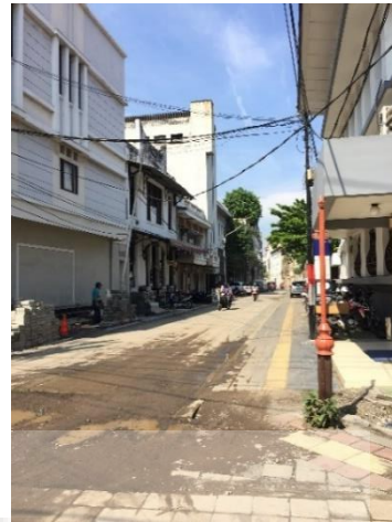
Gambar 4.2 Kondisi Jalan Sendowo Timur Sumber: Dokumentasi Pribadi
