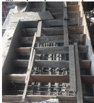
Gambar 3.17 Bekisting Tangga
