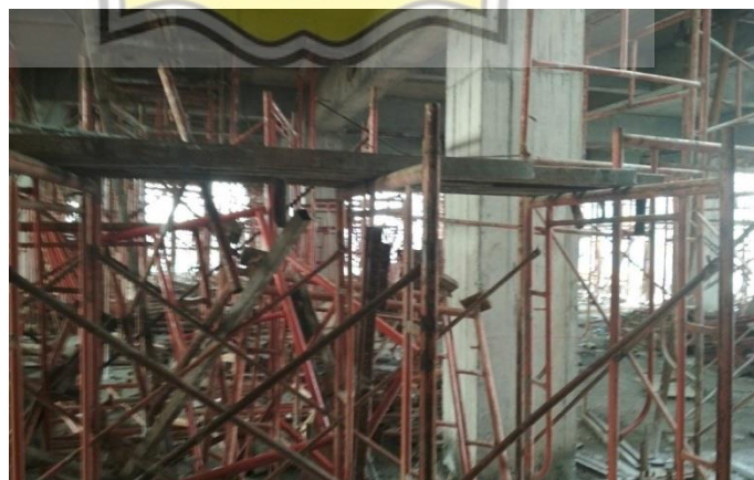
Gambar 3.23 Pembongkaran Bekisting Balok dan Pelat Lantai
