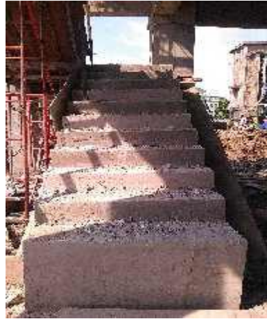
Gambar 3.19 Pembongkaran Bekisting Tangga
