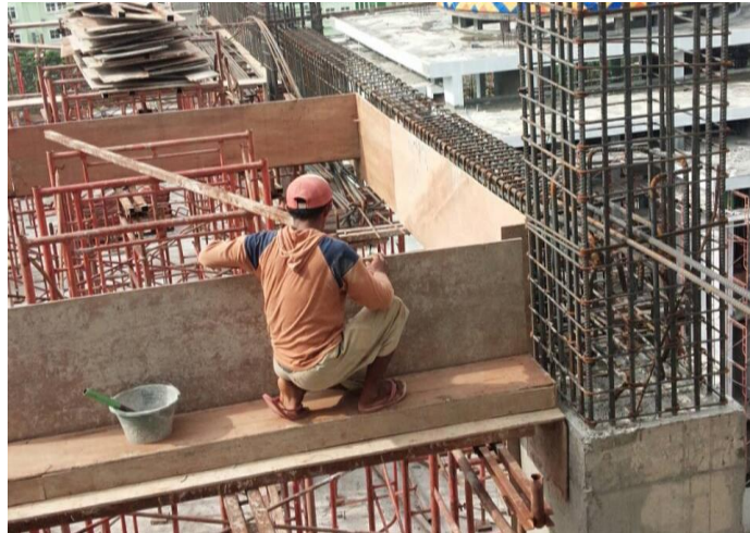
Gambar 3.20 Pemasangan Bekisting Balok
