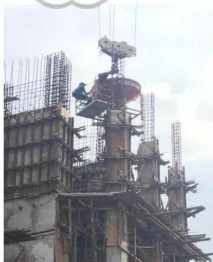
Gambar 3.26 Bekisting Core Wall yang Telah Dipasang
