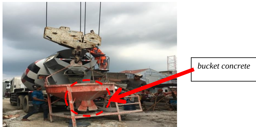
Gambar 3.13 Proses Penuangan Beton
