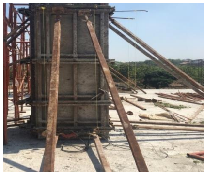
Gambar 3.10 Bekisting Kolom
