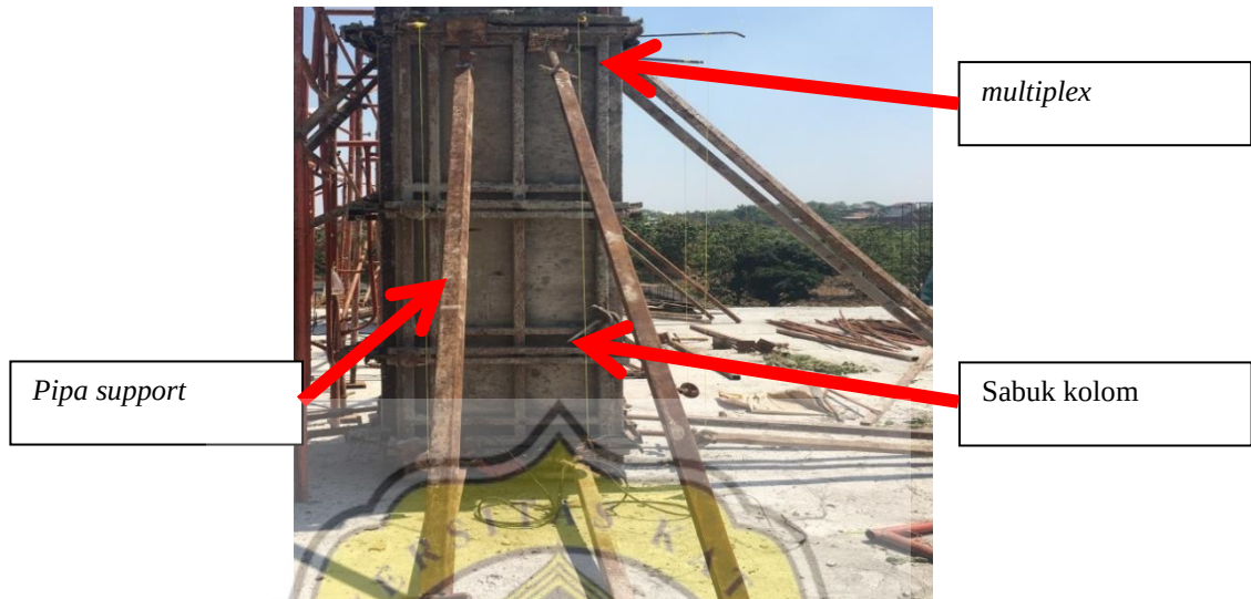
Gambar 3.11 Bagian-bagian Bekisting Kolom
