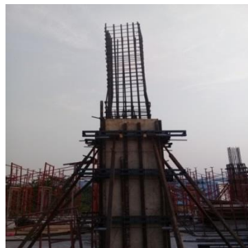
Gambar 3.6. Bekisting Kolom yang Telah Terpasang
