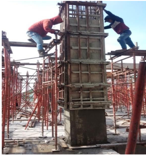
Gambar 3.15 Pembongkaran Bekisting Kolom
