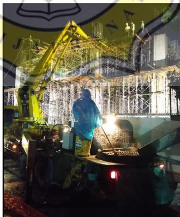
Gambar 3.38 Pengecoran dengan truck *concrete pump*
