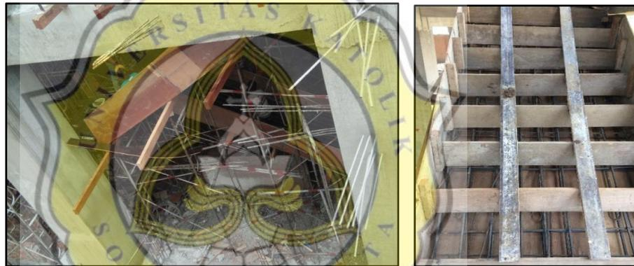
Gambar 3.31 Pemasangan Bekisting Struktur Tangga
