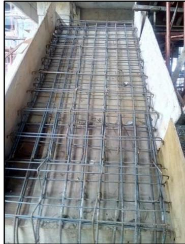
Gambar 3.32 Penulangan Struktur Tangga
