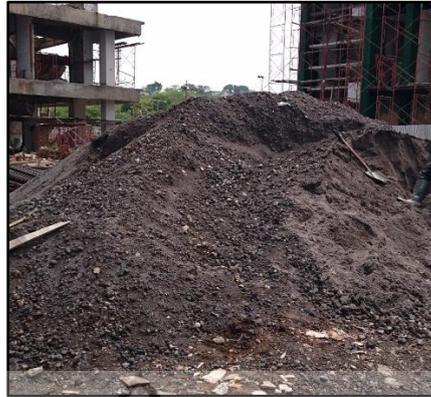
Gambar 3.49 Agregat halus (Pasir)
