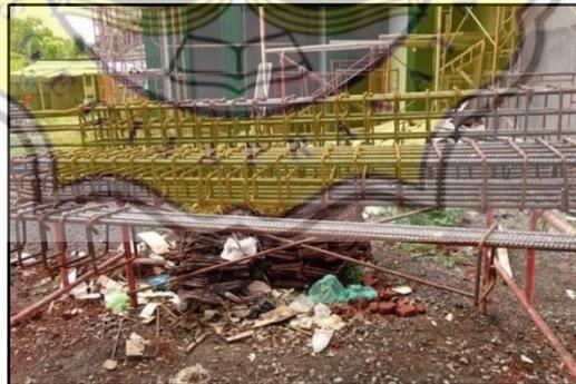
Gambar 3.34 Fabrikasi Penulangan Core Wall
