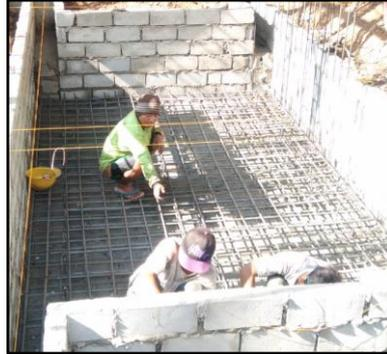
Gambar 3.63 Pemasangan wiremesh plat lantai dasar
