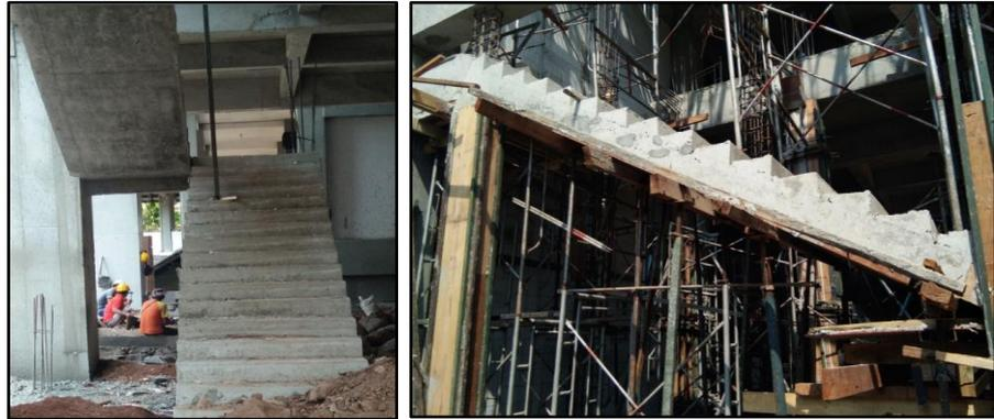
Gambar 3.33 Hasil Pengecoran Struktur Tangga
