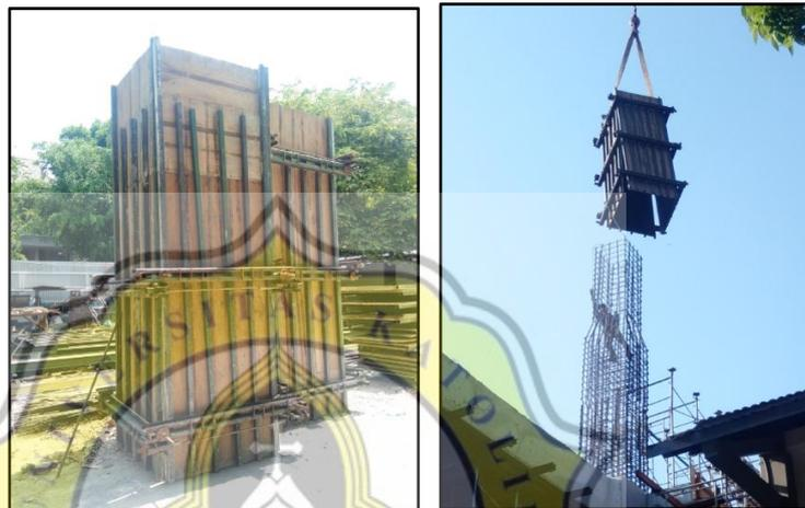
Gambar 3.18 Pembuatan dan Pemasangan Bekisting Kolom
