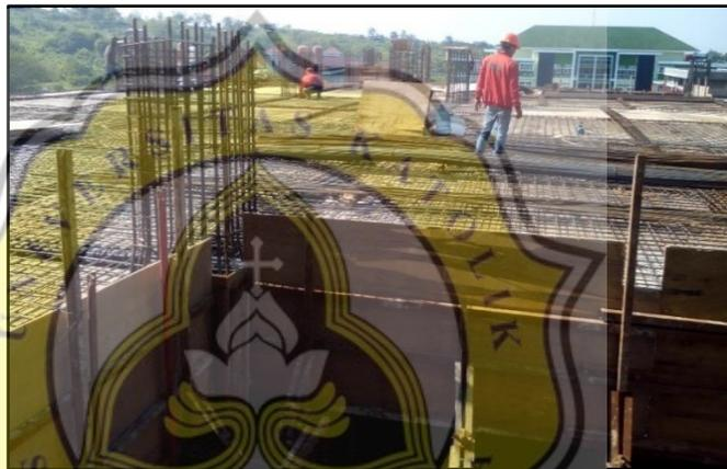
Gambar 3.27 Pemasangan Tulangan pada Pelat Lantai
