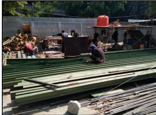
Gambar 3.16 Fabrikasi Penulangan dan Bekisting
