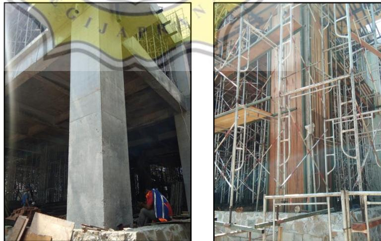
Gambar 3.21 Sesudah dan Sebelum Pelepasan Bekisting Kolom
