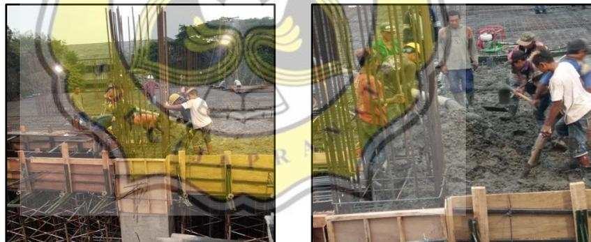
Gambar 3.28 Pengecoran Pelat lantai dan Balok
