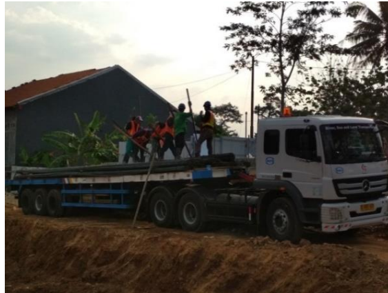
Gambar 3.36 Truck Material Sumber: Dokumentasi Proyek, 2018
