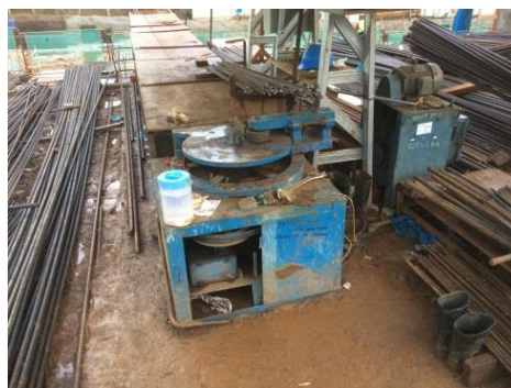
Gambar 3.41 Bar Bender Mesin Sumber: Dokumentasi Proyek, 2018
