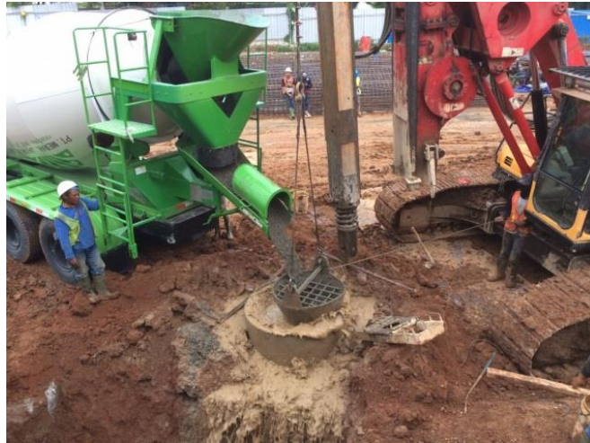
Gambar 3.24 Pengecoran Bored Pile Sumber : Dokumentasi Proyek, 2018
