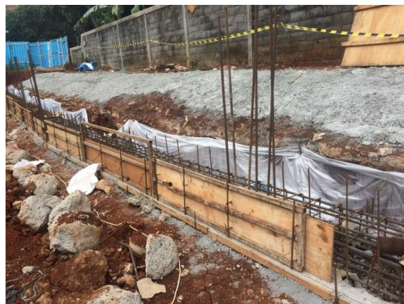
Gambar 3.29 Pemasangan Bekisting pada Capping Beam Sumber : Dokumentasi Proyek, 2018
