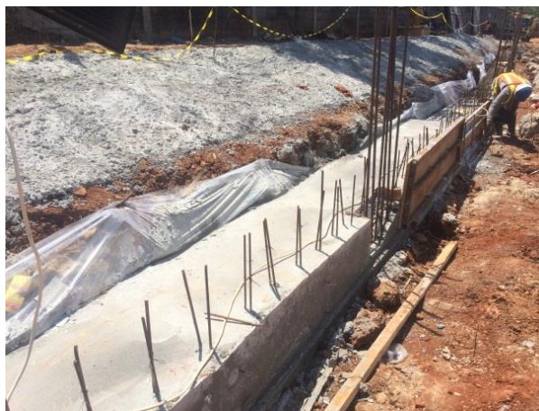
Gambar 3.30 Pelepasan Bekisting pada Capping Beam Sumber : Dokumentasi Proyek, 2018
