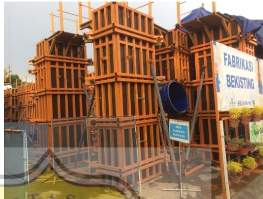
Gambar 3.54 Bekisting Knock Down Sumber: Dokumentasi Proyek, 2018
