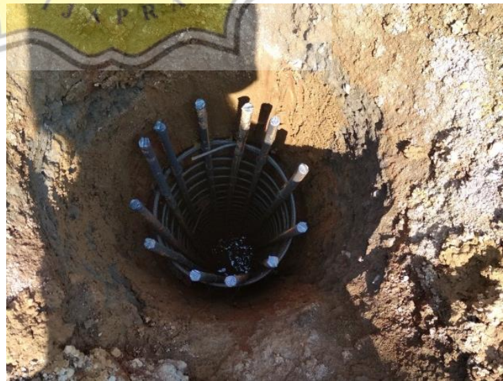
Gambar 3.14 Besi Tulangan Soldier Pile Sumber : Dokumentasi Proyek, 2018
