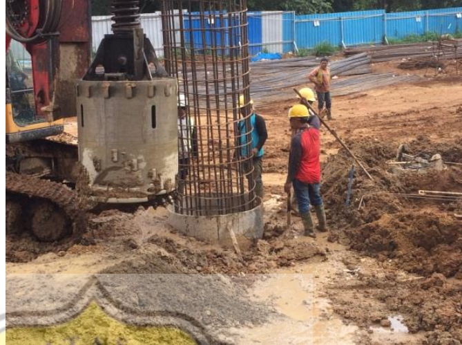
Gambar 3.22 Pemasangan Besi Tulangan Bored Pile Sumber : Dokumentasi Proyek, 2018
