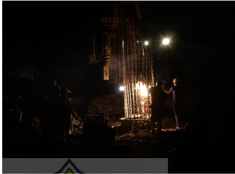
Gambar 3.59 Pekerja Lembur Sumber : Dokumentasi Proyek, 2018
