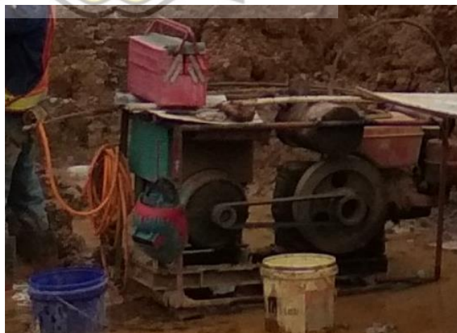
Gambar 3.43 Alat Las Karbit Sumber: Dokumentasi Proyek, 2018
