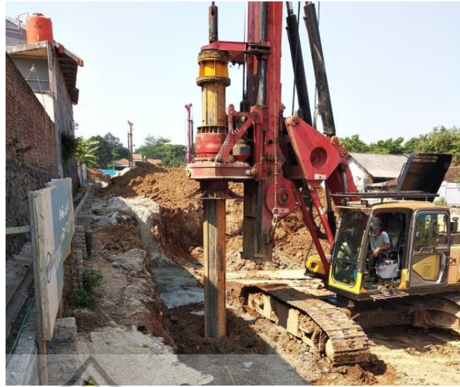
Gambar 3.11 Proses Pengeboran Soldier Pile Sumber : Dokumentasi Proyek, 2018
