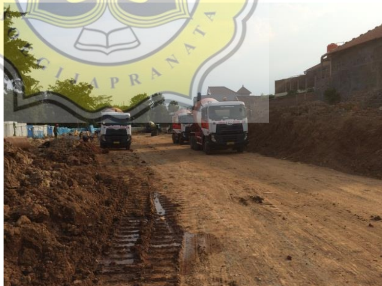
Gambar 3.8 Mobilisasi Alat dan Material Sumber : Dokumentasi Proyek, 2018
