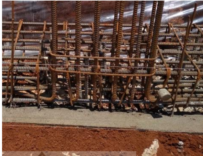
Gambar 3.28 Pemasangan Beton Decking Sumber : Dokumentasi Proyek, 2018
