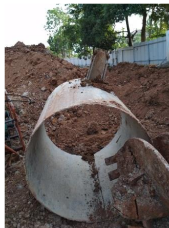
Gambar 3.47 Casing Bored Pile Sumber: Dokumentasi Proyek, 2018
