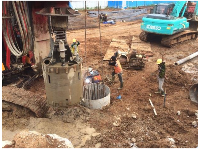
Gambar 3.23 Pemasangan Hanger Steel Sumber : Dokumentasi Proyek, 2018
