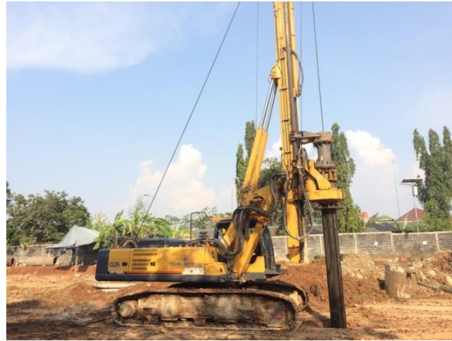
Gambar 3.37 Rotary Drilling Rig Sumber: Dokumentasi Proyek, 2018
