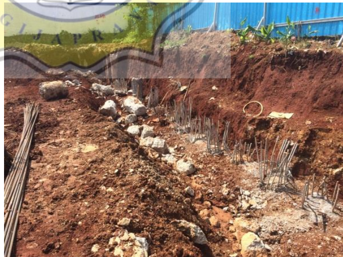
Gambar 3.26 Hasil Pengupasan SoldierPile Sumber : Dokumentasi Proyek, 2018
