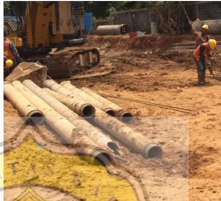
Gambar 3.46 Pipa Tremi Sumber: Dokumentasi Proyek, 2018
