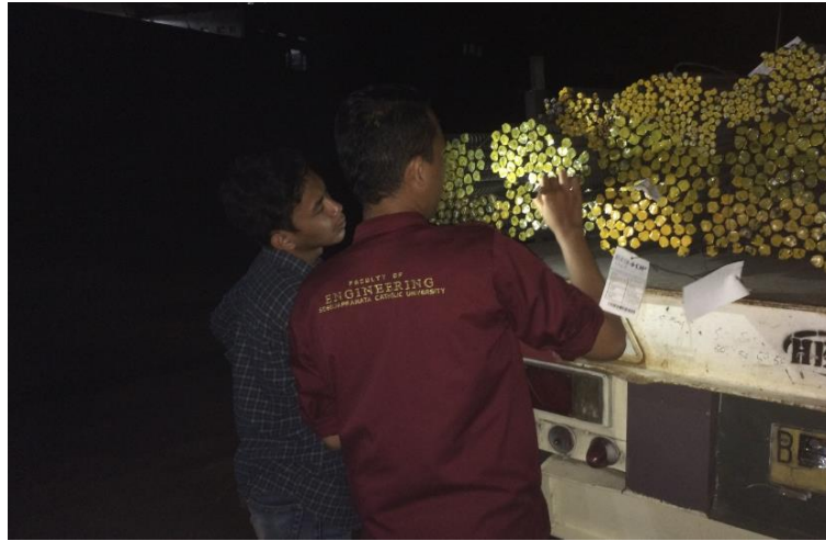
Gambar 3.61 Check List Material Besi Tulangan Sumber : Dokumentasi Proyek, 2018
