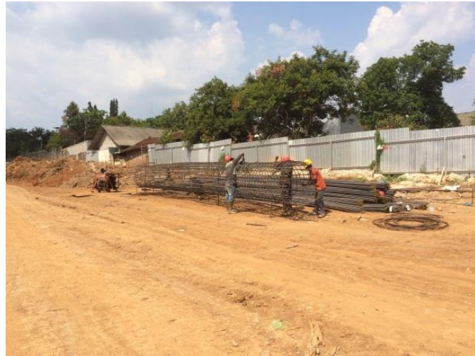
Gambar 3.10 Pabrikasi Besi Tulangan Sumber : Dokumentasi Proyek, 2018
