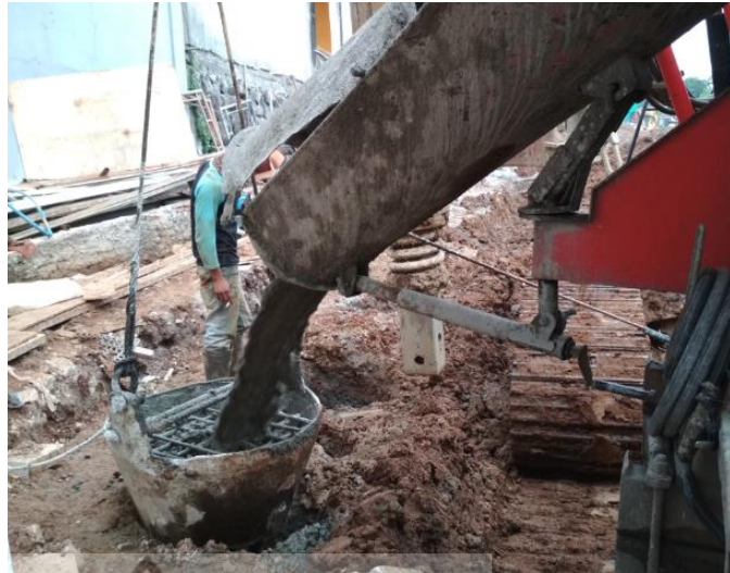
Gambar 3.16 Proses Pengecoran Soldier Pile Sumber : Dokumentasi Proyek, 2018
