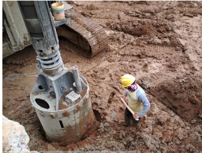
Gambar 3.19 Pengeboran Bored Pile Sumber : Dokumentasi Proyek, 2018
