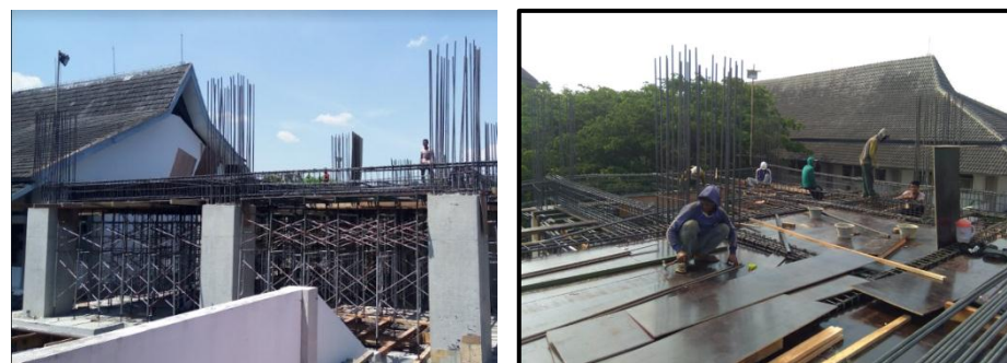
Gambar 3.24 Pemasangan Bekisting Pelat Lantai
