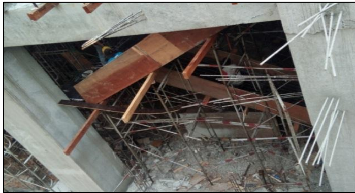
Gambar 3.30 Pemasangan Perancah Tangga
