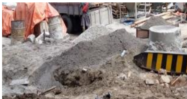
Gambar 3.48 Agregat Halus dan Kasar
