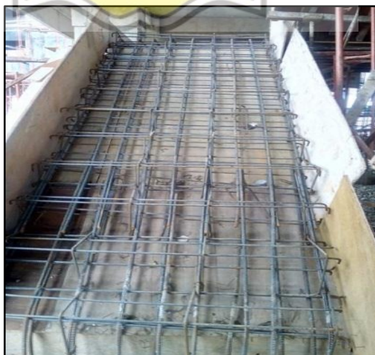
Gambar 3.31 Pemasangan Bekisting Tangga
