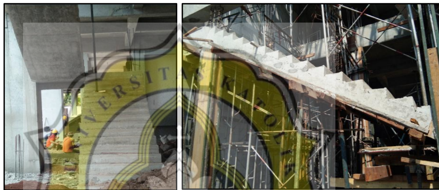
Gambar 3.33 Hasil Pengecoran Struktur Tangga
