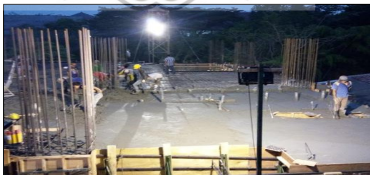
Gambar 3.27 Perataan Permukaan Pelat Lantai
