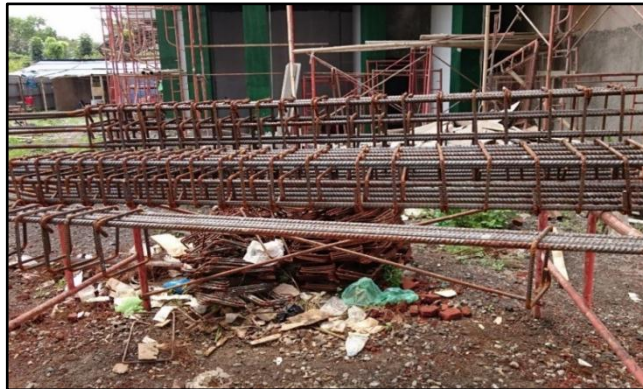
Gambar 3.35 Fabrikasi Dan Penulangan Core Wall
