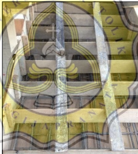
Gambar 3.32 Penulangan Struktur Tangga
