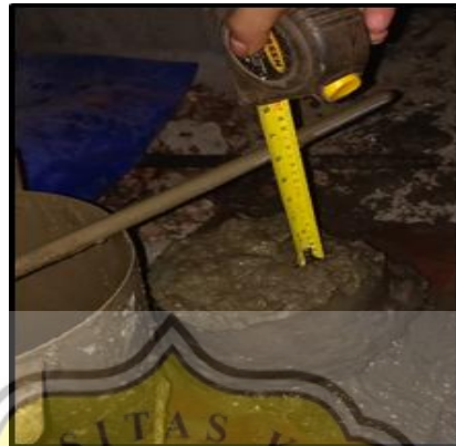
Gambar 3.17 Uji Slump Test Kolom di Lapangan
