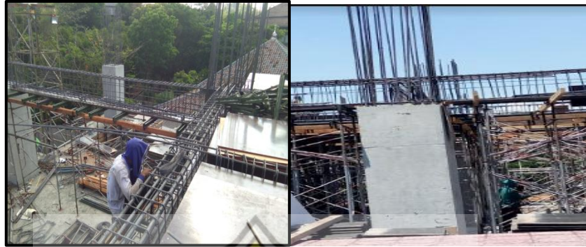
Gambar 3.23 Pemasangan Tulangan Balok
