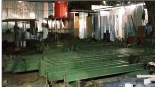
Gambar 3.14 Fabrikasi Penulangan dan Bekisting
