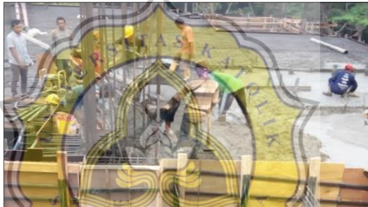
Gambar 3.26 Pengecoran Pelat Lantai dan Balok
