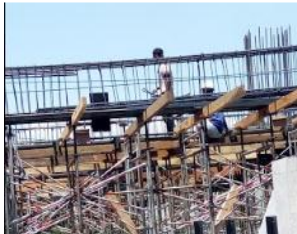
Gambar 3.22 Pemasangan Bekisting Balok
