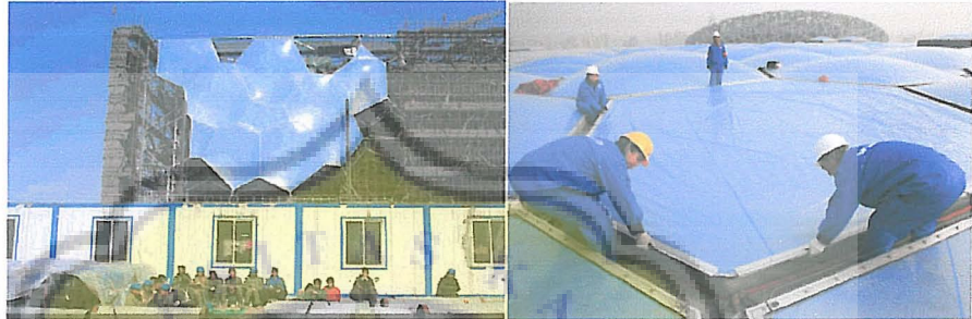
Gambar 5.8 Pengerjaan rangka struktur dan pelingkup Water Cube. Sumber: http://scaq.blogspot.com/2007_08_01_archive.html&imgurl=http://2.bp.blogspot.com/ , 25 Februari 2011, pukul 12.36; dan http://www.chinadaily.com.cn/2008/2006-12/27/content_768589.htm , 28 Februari 2011, pukul 14.25.
