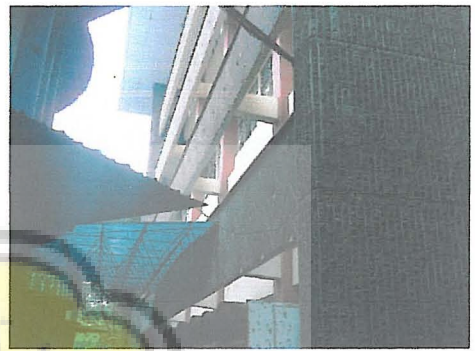
Gambar No. 20 Gedung bertingkat yang menggunakan elemen baru alam sebagai ornamen Sumber: dokumen pribadi
