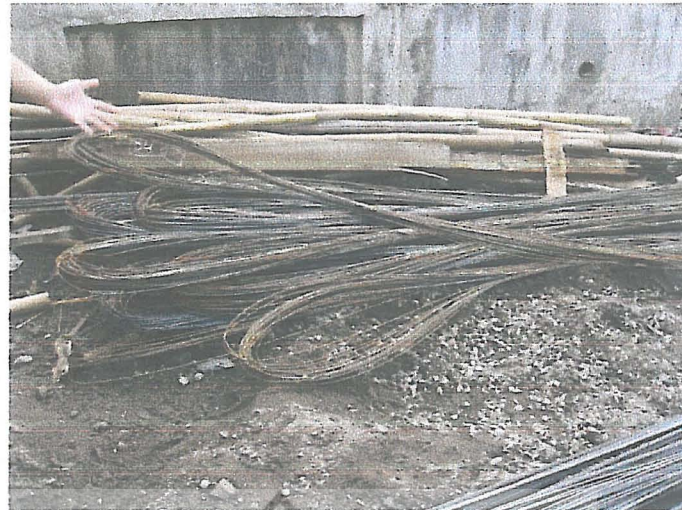
Gambar 4.6. Tumpukan Baja Tulangan.
