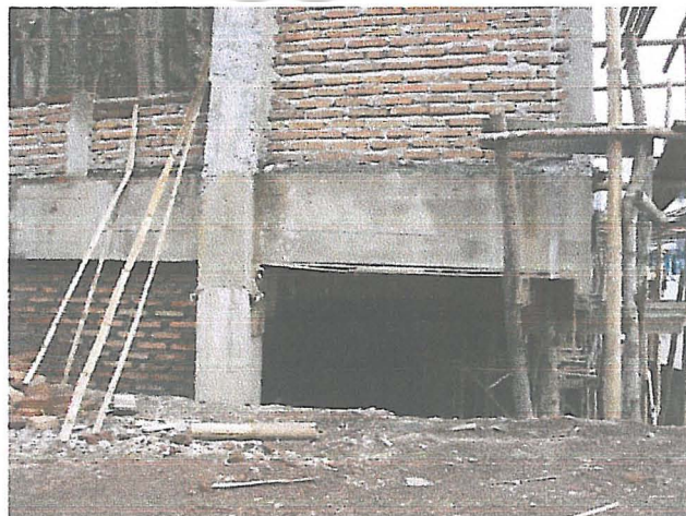
Gambar 6.3. Pembesaran Balok Kantilever.
