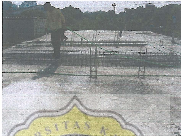
Gambar 4.27. Perawatan Balok dan Plat Lantai.
