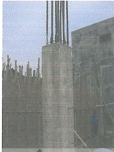
Gambar 4.23. Setelah Begesting Beton di buka.
