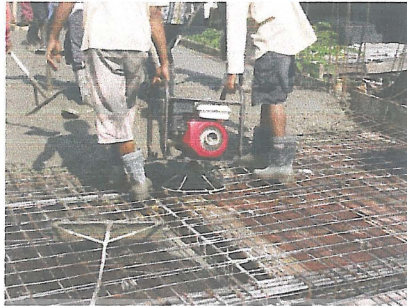
Gambar 4.26. Pengecoran Balok dan Plat Lantai.
